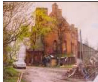
Links ein Förderturm, der durch eine Dachöffnung Getreide einfüllte.
